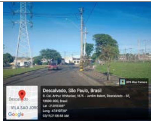
Cenário: Lombada sem sinalização de advertência
