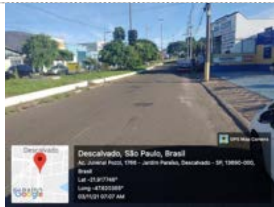
Cenário: Reforçar pintura de balizamento, sinalização horizontal apagada
