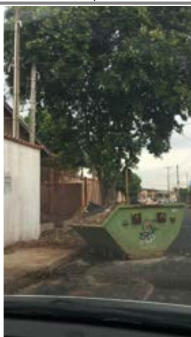
Cenário: Rua João Vendramini - obstrução de calçada
