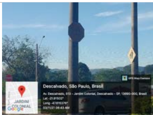
Cenário: Placa de regulamentação danificada e não visível
