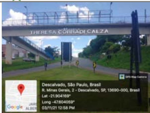
Cenário: Passarela sobre via urbana
